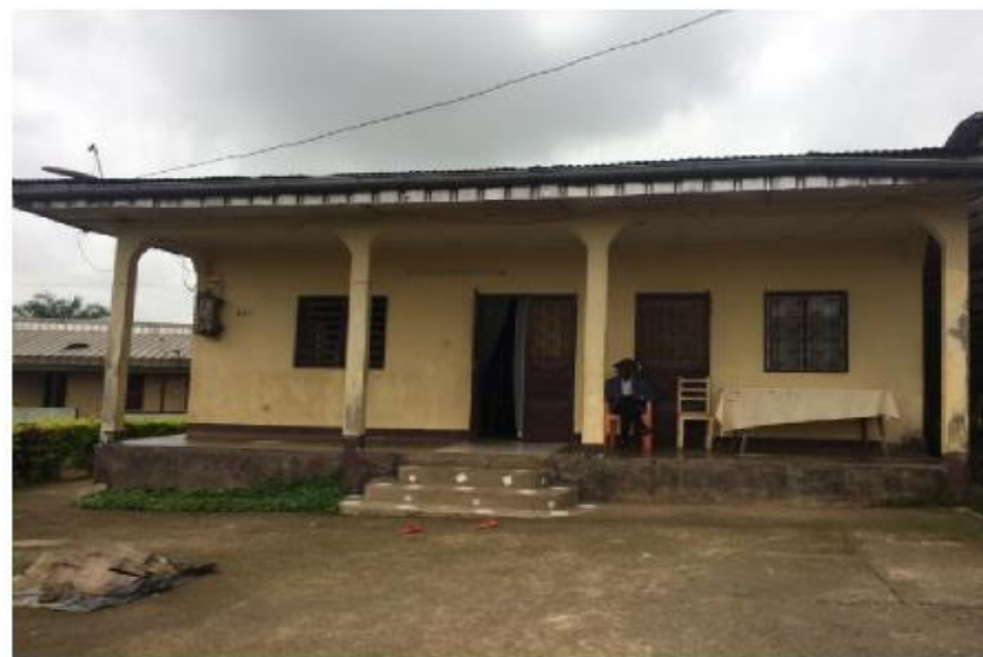
Logement moderne en matériaux définitifs
