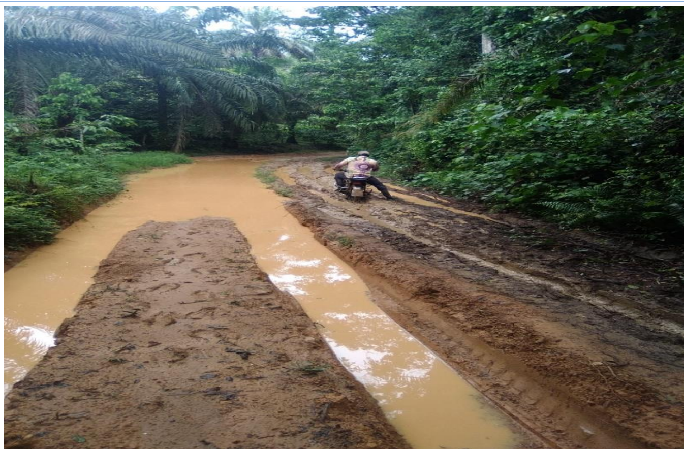
Image 2: Voie en terre impraticable (Accès Badjoki)
